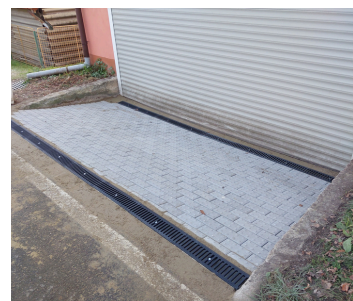
Vjezd po opravě
