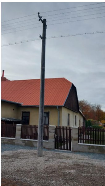
Sloup po výměně
